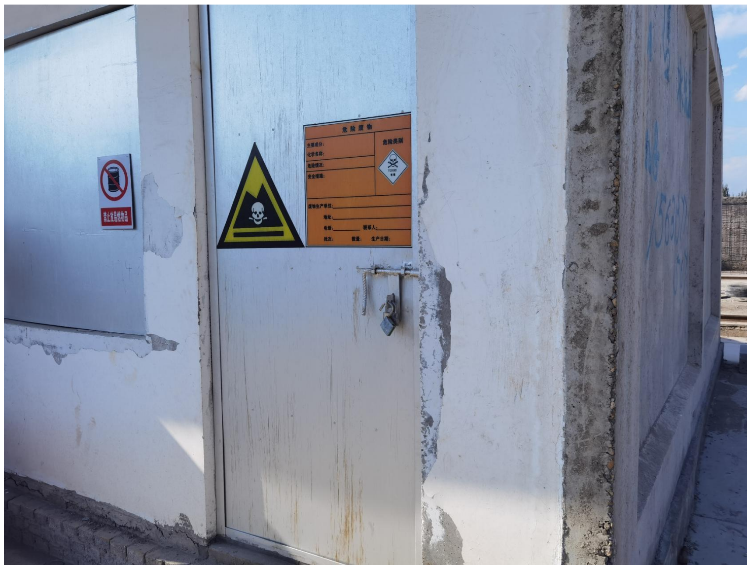
附图四 危废暂存间
