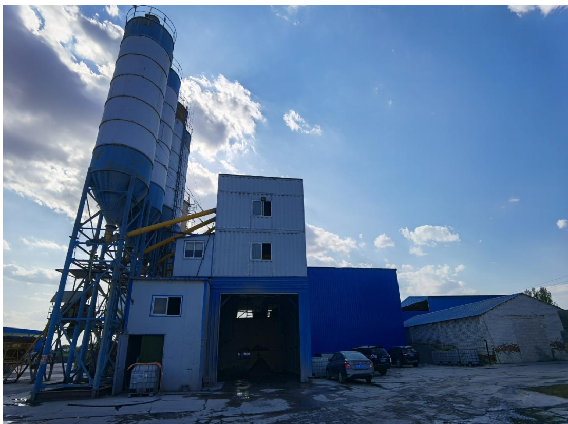
图 2-2 HZS120 混凝土生产线
